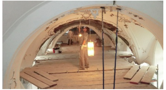
Auf dem Gerüst unter dem Gewölbe
