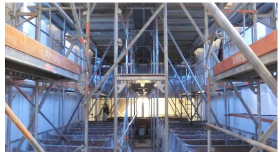
Die eingerüstete Kirche
