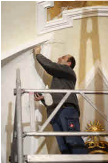
Restaurator Markus Pfister beseuert Risse an den Stuckleisten aus.
