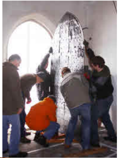
Die restaurierte Kirchentür wird wieder eingesetzt.
